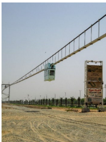
Рисунок 7 – Полугибкая путевая структура. Конструкция рельса. Центр uSky, г. Шарджа (ОАЭ), 2024 г.
